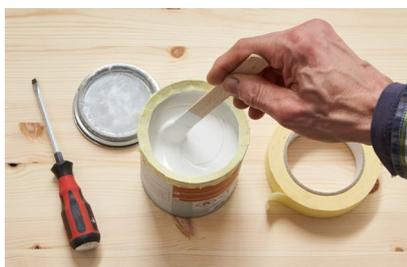
Öffnen Sie die Dose des Haftgrunds mit einem Schraubenzieher. Das geht am besten, wenn Sie Stück für Stück den Deckel rundum anheben. Wird der Deckel nur an einer Stelle kräftig angehoben, kann er sich verbiegen und schließt später eventuell nicht mehr vollständig.
