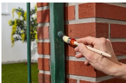
Tragen Sie nach **8 Stunden Trockenzeit** eine zweite Schicht **Alpina Anti-Rost Metallschutz-Lack** auf. Achten Sie auch hier wieder auf eine gleichmäßige Verteilung des Lacks.
