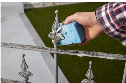
Als nächstes sollten Sie etwaige Verschmutzungen zuerst mit Seifenlauge und anschließend mit klarem Wasser abwaschen. Lassen Sie Ihr Objekt gut trocknen, denn der **Alpina Anti-Rost Metallschutz-Lack** haftet nur auf trocknen Untergründen.
