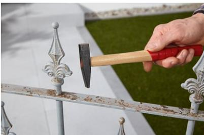
Für einen effektiven Metallschutz müssen Sie zuerst alle Rostnester mit einem Hammer aufschlagen.
