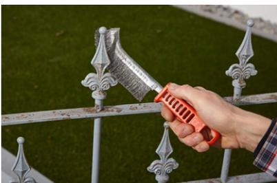
Bürsten Sie anschließend grobe Roststellen mit einer Drahtbürste ab. So entfernen Sie losen Rost. Der **Alpina Anti-Rost Metallschutz-Lack** hält zwar auf Rost, jedoch muss der Untergrund tragfähig sein.
