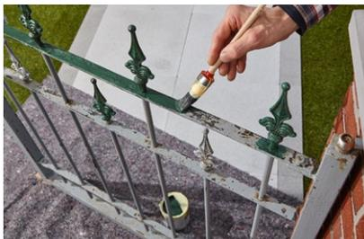
Nun kann es losgehen: Streichen Sie den Metallzaun mit einer satten Schicht **Alpina Anti-Rost Metallschutz-Lack**.
